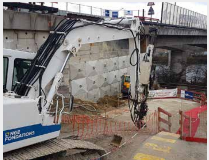
Exemple de travaux de confortement du viaduc de Gennevilliers
